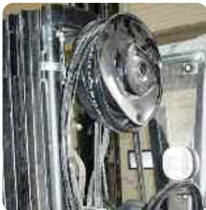
► Slangvinda och slangar oanvändbara
